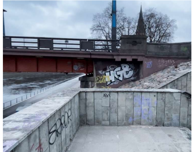
6. Sustojimo aikštelė laiptuose ties krantine žiūrint Vakarų kryptimi link Aleksoto tilto.
