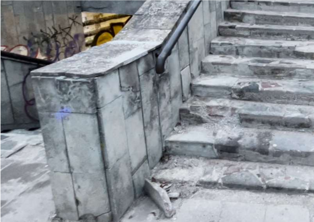
Pavekslas 12. Vaizdas į skiriamąją sienutę virš išėjimo į Karaliaus Mindaugo prospektą, iš pakrantės pusės. Matomi pažeidimai sienos apdailoje, plyšiai, apdailos nubyrėjimai, senų remontų žymės. Laiptai suirę, netvarkingi, naudotis jais nėra saugu.
