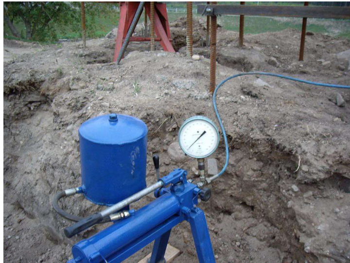
8.3 pav. Rankinė hidraulinė siurblinė
