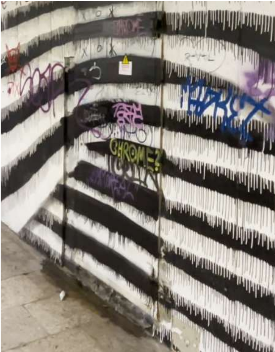
Paveikslas 7. Vaizdas į duris tunelio sienoje. Durys veda į nenaudojamą patalpą.
