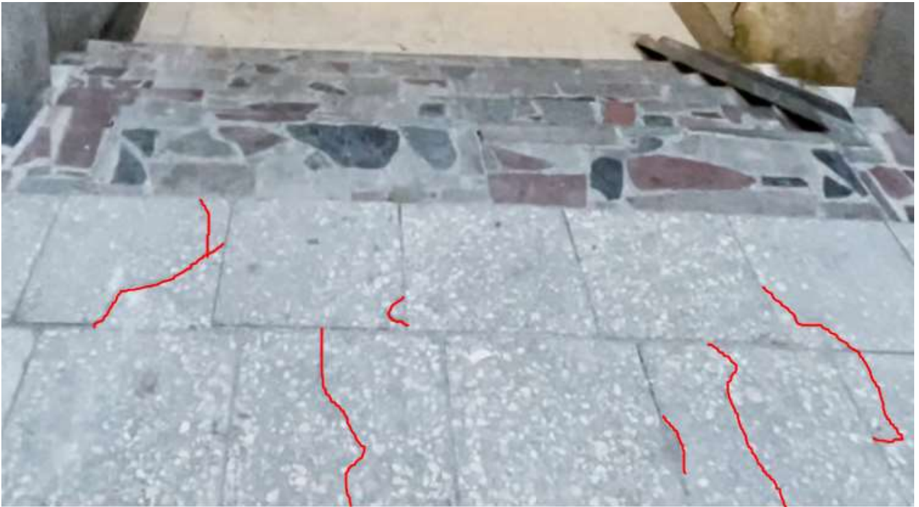
Pavekslas 4. Vaizdas į tunelio prieigas iš Kuzmos gatvės. Matoma suirusi grindų danga, matomi daugybiniai plyšiai ir įtrūkimai.
